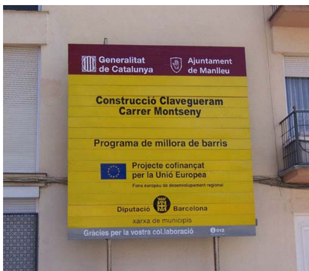
Obres clavegueram carrer Montseny
